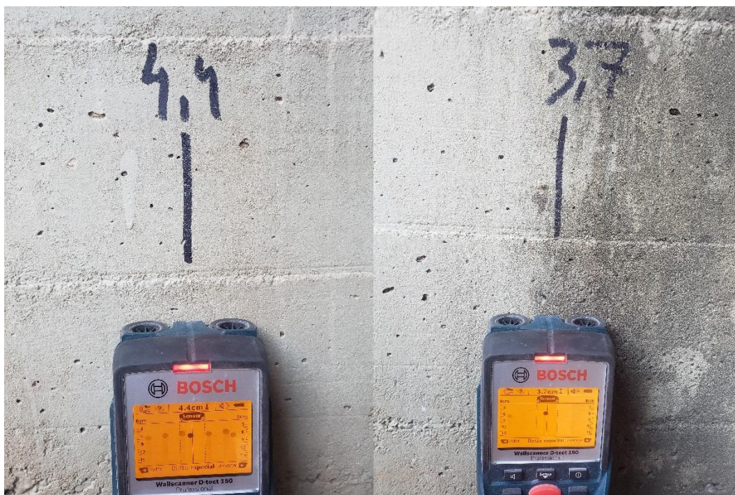
Figure 59: Ensaio de pacometria - Identificação do posicionamento da armadura existente
