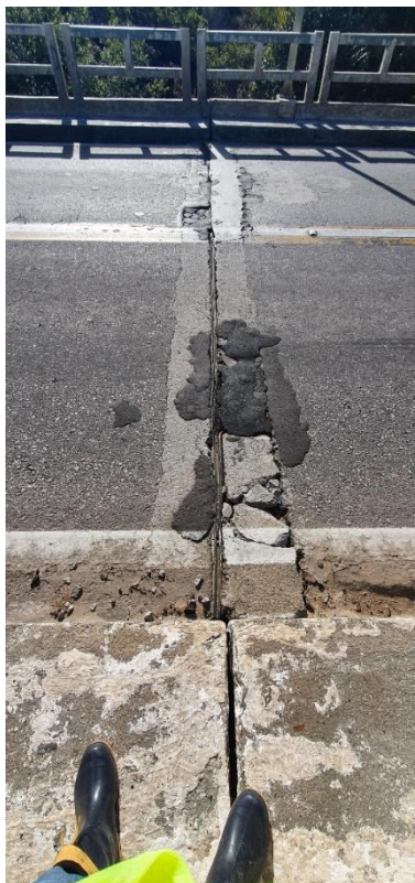
Figure 52 – Pavimento - Junta de dilatação no encontro E1
