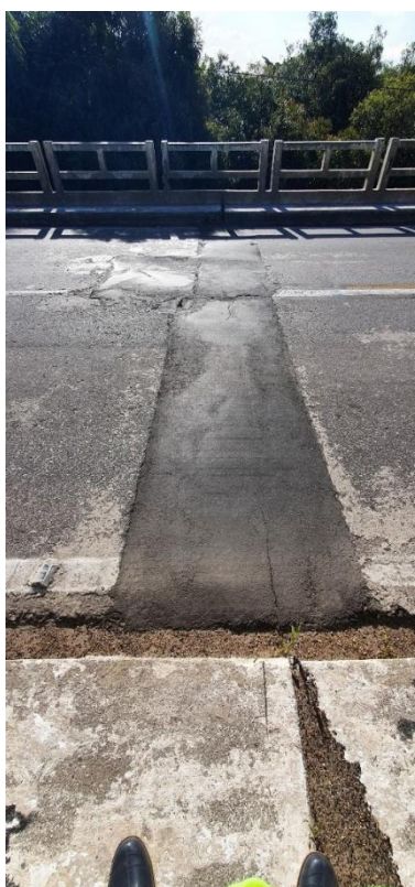
Figure 49 – Pavimento - Junta de dilatação no encontro E2
