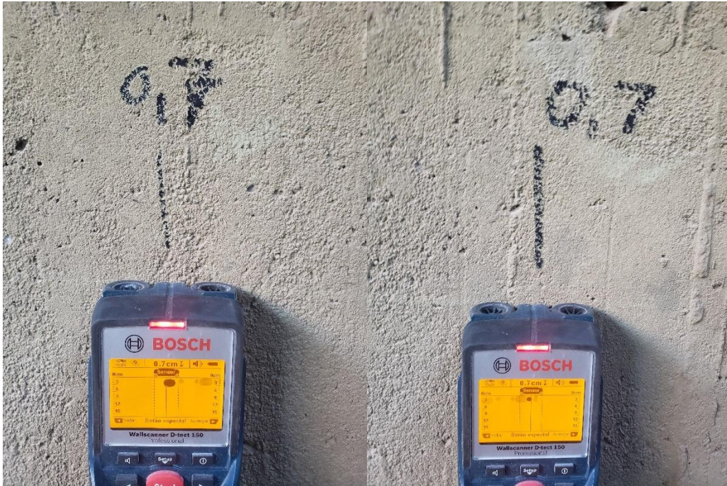
Figure 63: Ensaio de pacometria - Identificação do posicionamento da armadura existente
