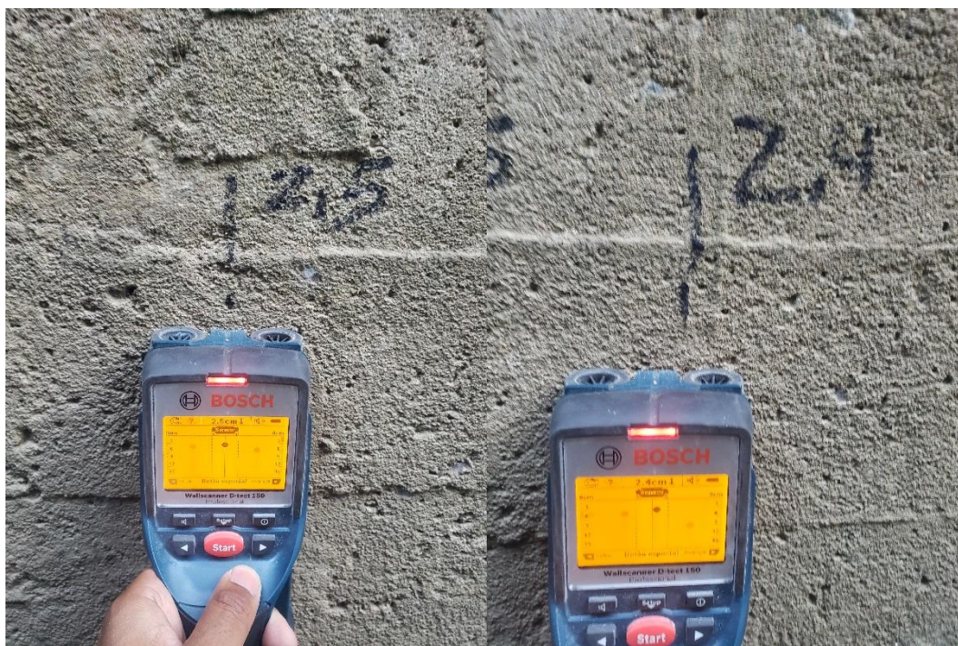
Figure 69: Ensaio de pacometria - Identificação do posicionamento da armadura existente
