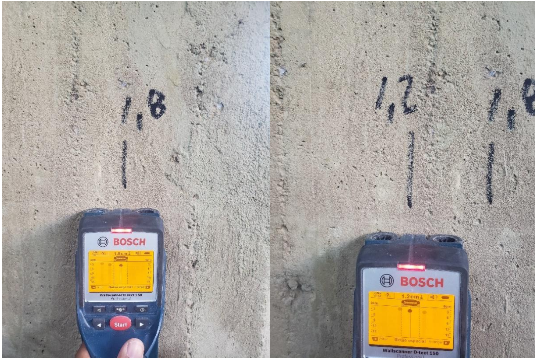
Figure 65: Ensaio de pacometria - Identificação do posicionamento da armadura existente
