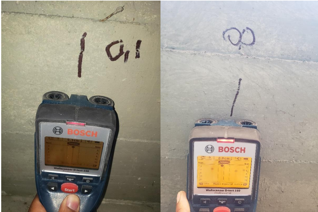
Figure 55: Ensaio de pacometria - Identificação do posicionamento da armadura existente
