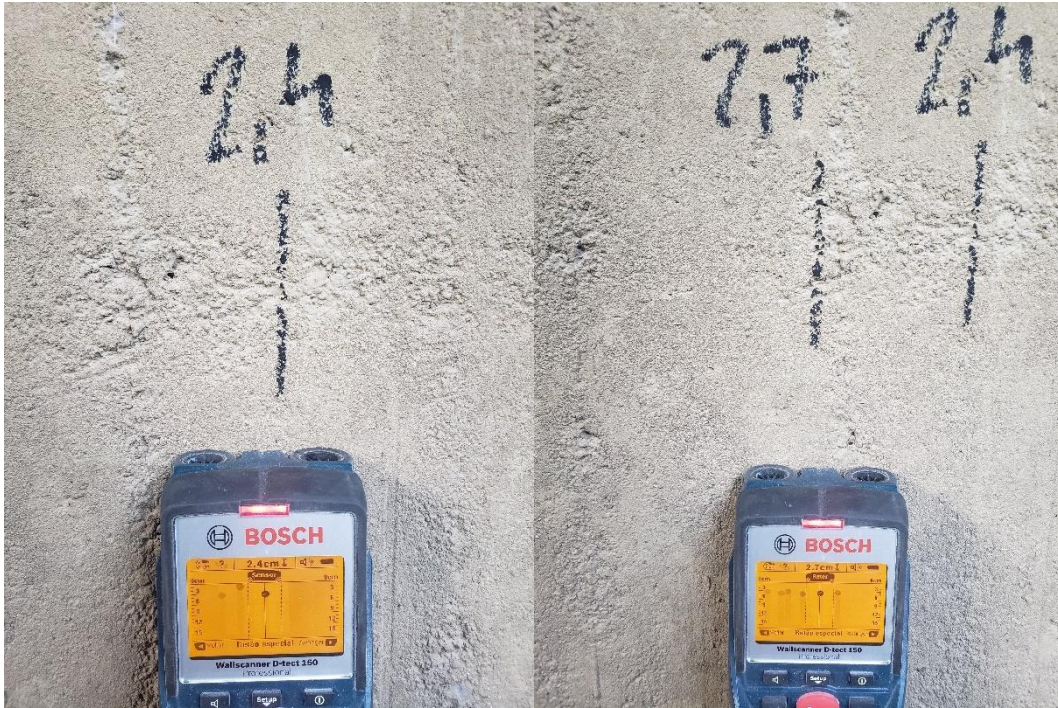
Figure 61: Ensaio de pacometria - Identificação do posicionamento da armadura existente
