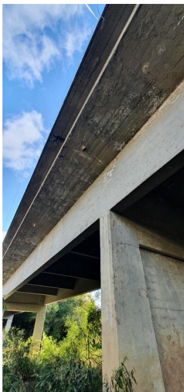
Figure 31 – Balanço - vista inferior balanço
