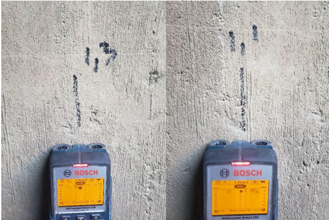
Figure 67: Ensaio de pacometria - Identificação do posicionamento da armadura existente
