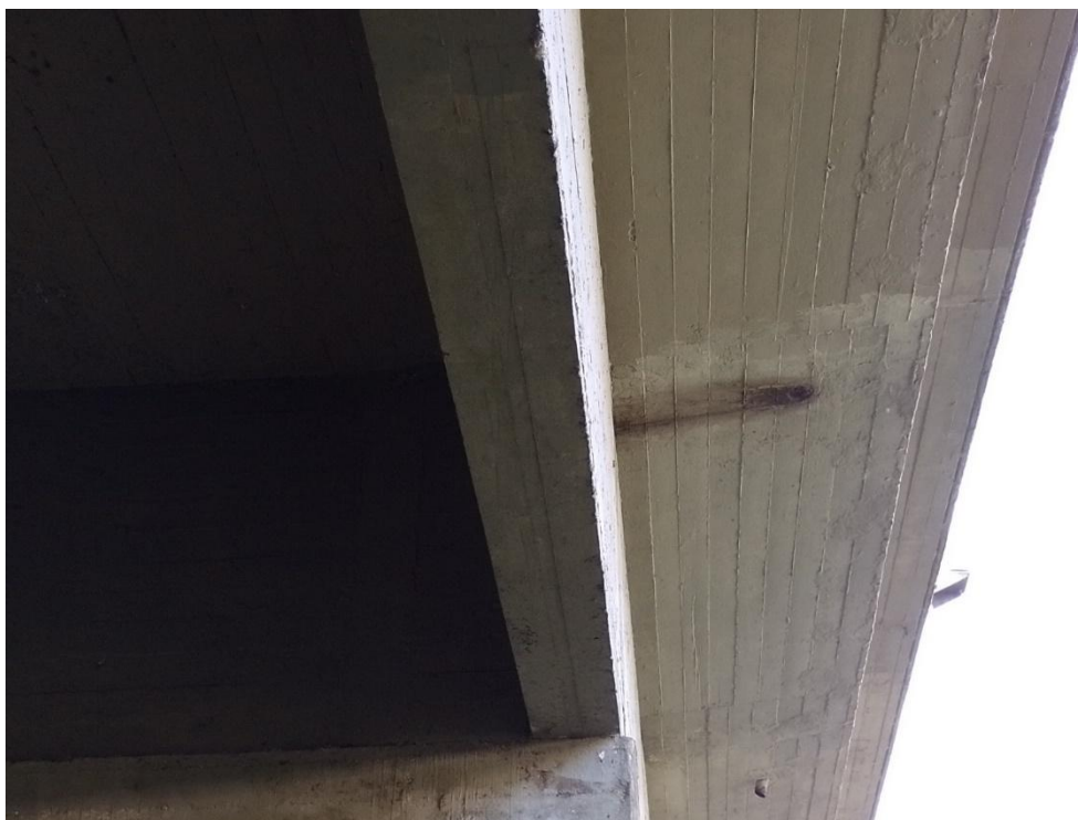
Figure 42 – Balanço - Percolação de água
