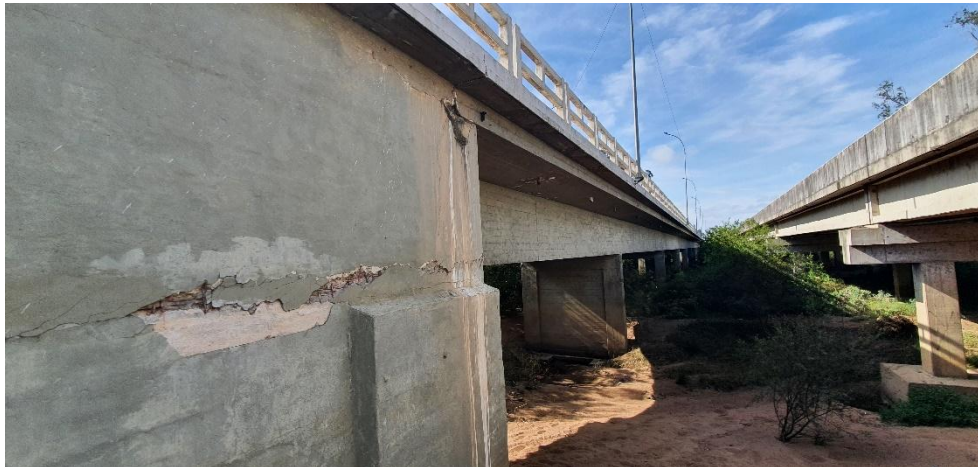
Figure 2 - Vista geral da Ponte
